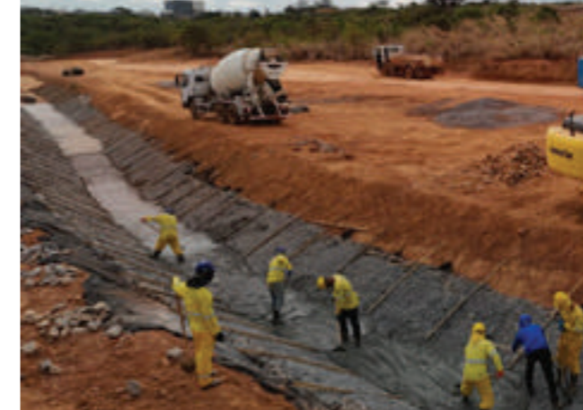
Goinfra recupera passivos ambientais para reativação do Aeroporto de Cargas de Anápolis
