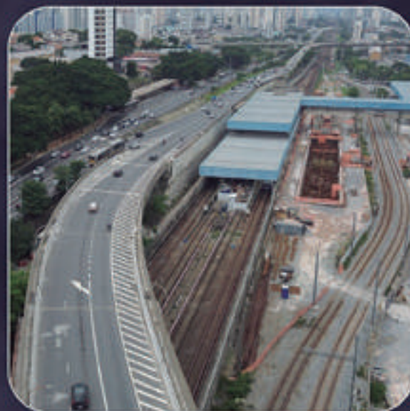
VIADUTO CARLOS DE CAMPOS
