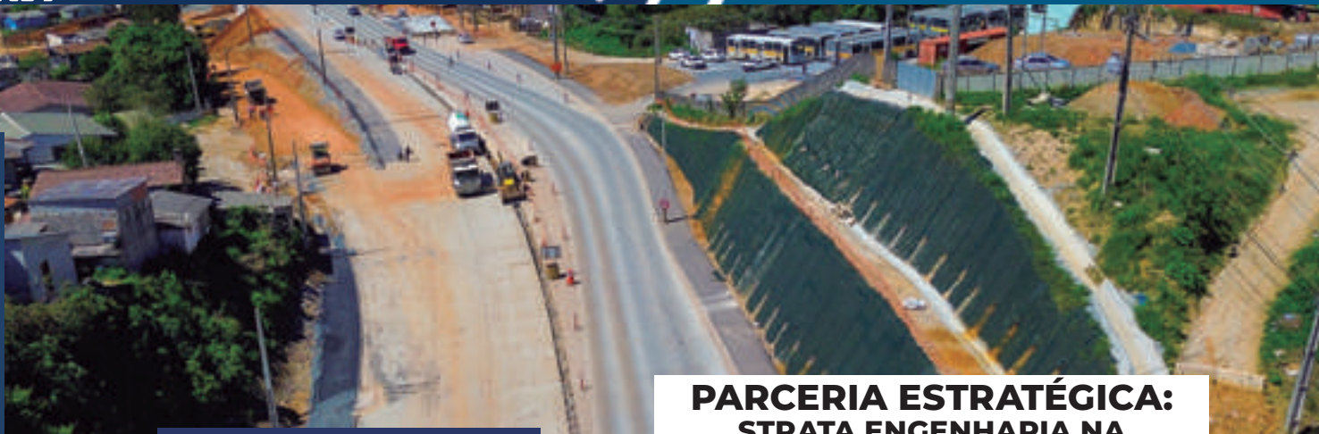
Duplicação da Rodovia dos Minérios
