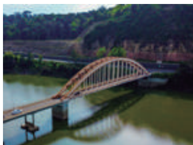
Ponte histórica em União da Vitória
