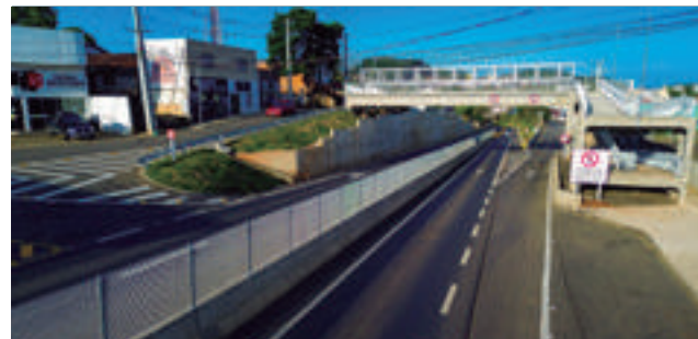
Travessia Urbana de Imbau
