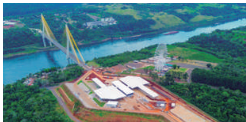
"Ponte da Integração" - Segunda ponte entre Brasil e Paraguai
