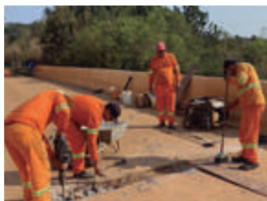
Obras em andamento na Ponte sobre o Rio Iapó, em Castro
