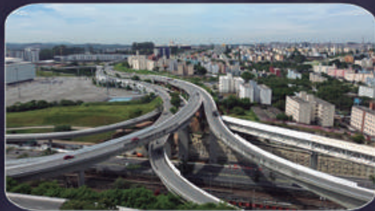
COMPLEXO VIÁRIO ARIETA
