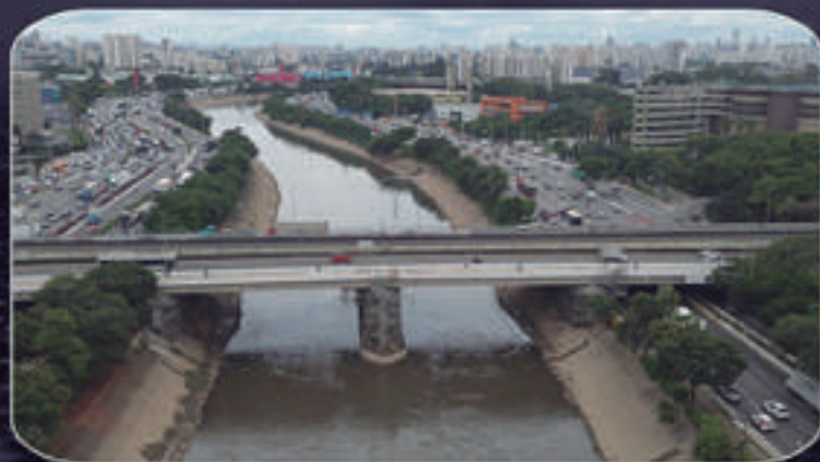
PONTE CRUZEIRO DO SUL
