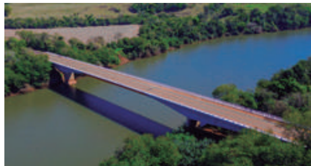
Ponte da PR-364 em Assis Chateaubriand: Mais uma OAE recuperada, reforçando a segurança e a infraestrutura viária do Paraná
