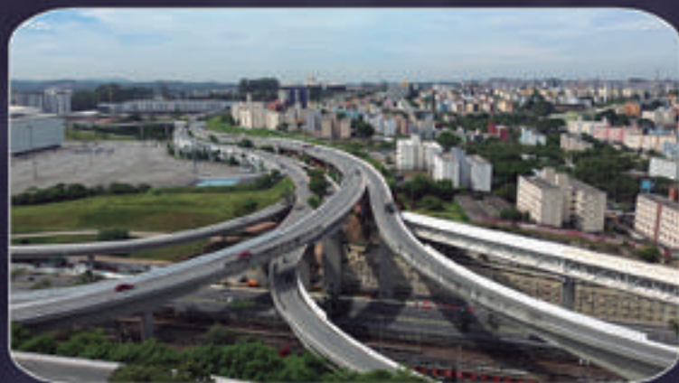
COMPLEXO VIÁRIO ARIETA
