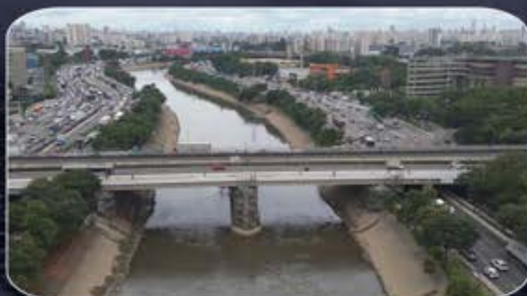
PONTE CRUZEIRO DO SUL
