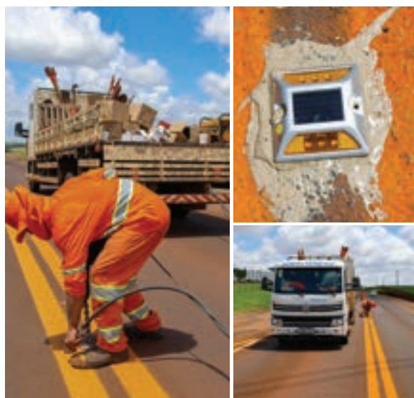
Instalação de tachas de LED na PR-486, reforçando a visibilidade noturna e a segurança viária
