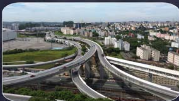
COMPLEXO VIÁRIO ARIETA
