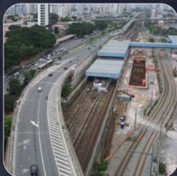
VIADUTO CARLOS DE CAMPOS
