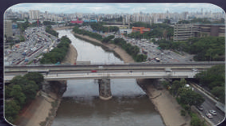
PONTE CRUZEIRO DO SUL
