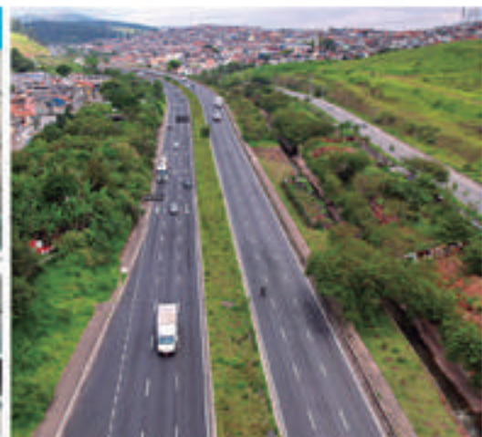
Execução de serviços de conservação e manutenção de malha viária (Av. Jacú Pêssego, em ambos os sentidos), em São Paulo (capital)
