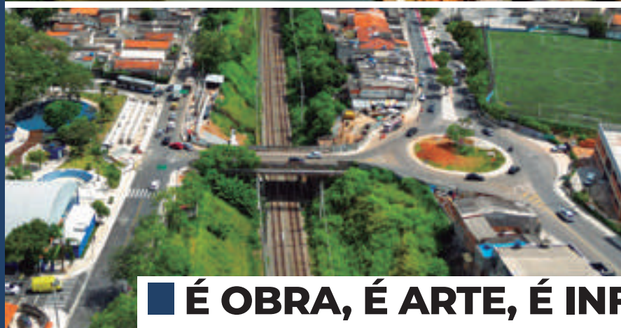
Ponte Engenheiro Ary Torres
