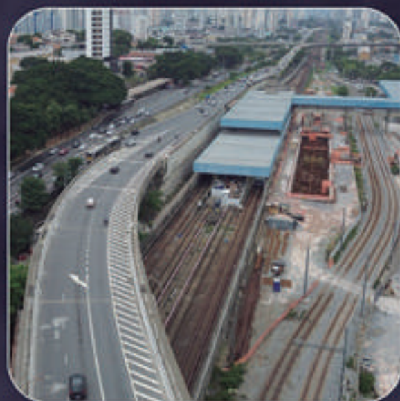
VIADUTO CARLOS DE CAMPOS
