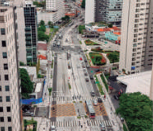
Requalificação da Avenida Santo Amaro e reforma do Corredor de Ônibus Santo Amaro, São Paulo - SP
