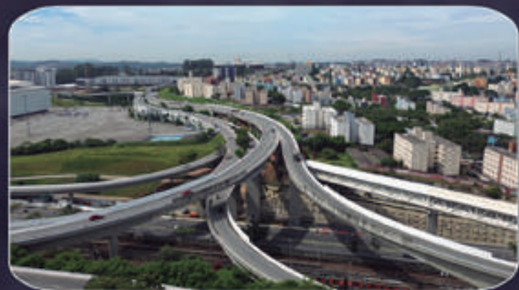
COMPLEXO VIÁRIO ARIETA
