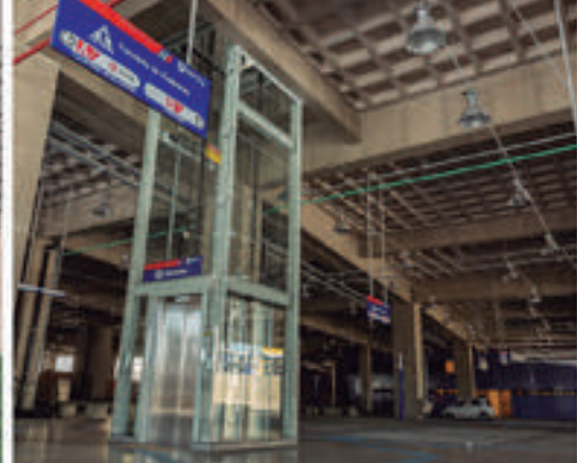
Terminal de passageiros, em Carapicuíba - SP, do Corredor Metropolitano Itapeví - Osasco
