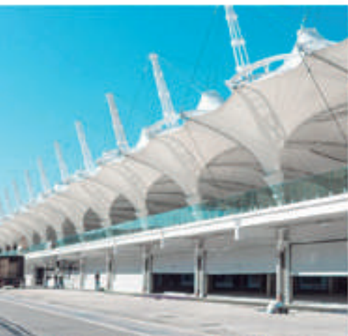
Reforma dos boxes e implantação de cobertura em estrutura metálica treliçada, com membrana tensionada, no Autódromo de Interlagos
