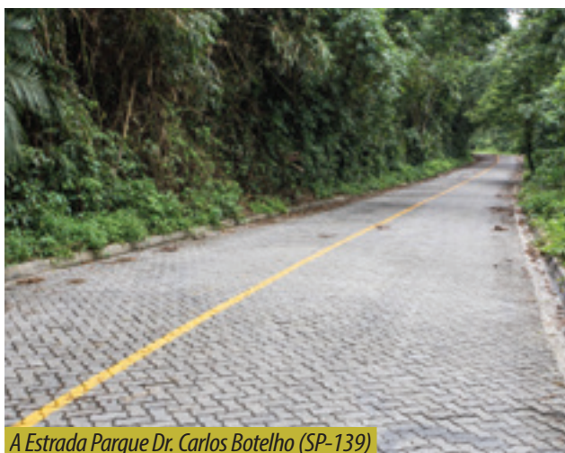
Implantação e pavimentação de 2ª pista (Duplicação da SP-147)
