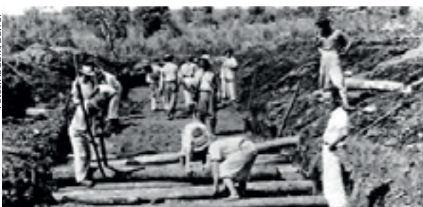
Técnica de troncos de árvores utilizada na abertura de estradas em 1934 (arquivo Biblioteca do DER)
