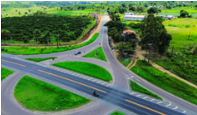
Entroncamento da BR-101 e a SE-285 - Aruá
