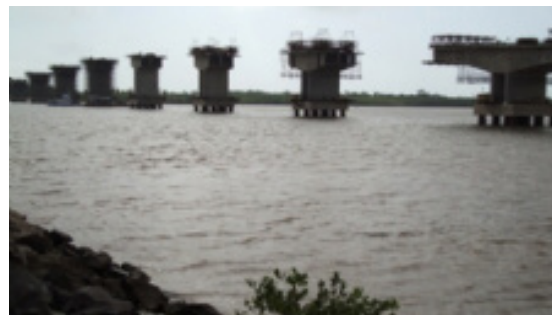
Início das obras da ponte João Alves Aracaju - Barra dos Coqueiros
