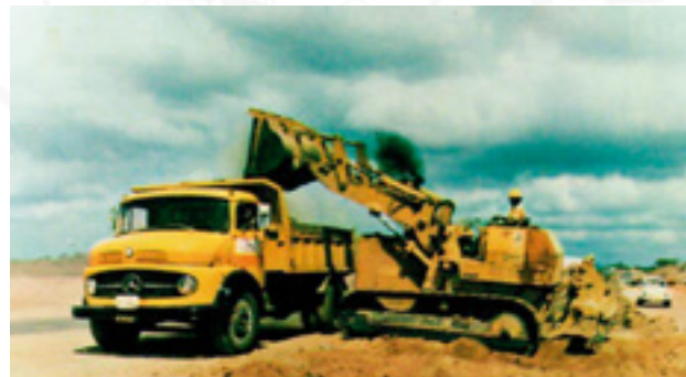
Caçamba e Máquina do DER-SE trabalhando
