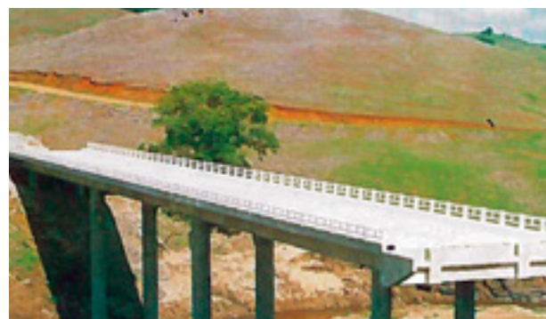
Ponte sobre o Rio Sergipe na Rodovia Nossa Senhora das Dores. Serra do Machado com 100,00m de vão
