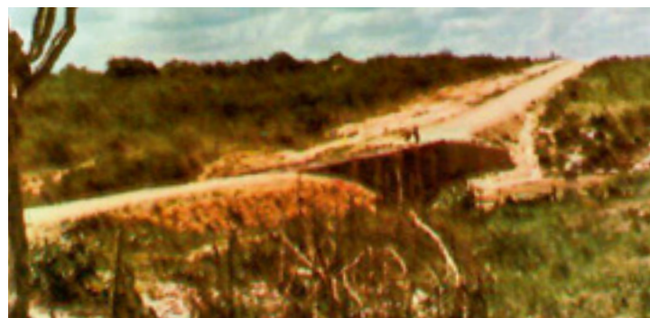
Rodovia SE-208. Trecho Poço Redondo - Canindé
