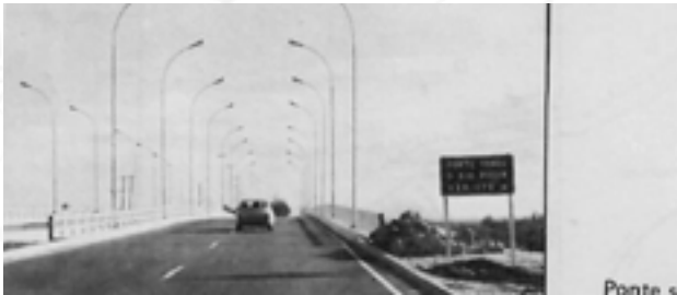
Duplicação da Ponte Aracaju e Atalaia
