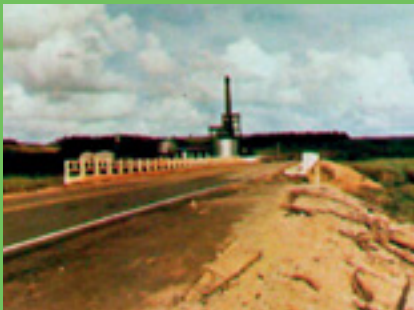
Ponte sobre o Rio Japarutuba. BR-101-Capela
