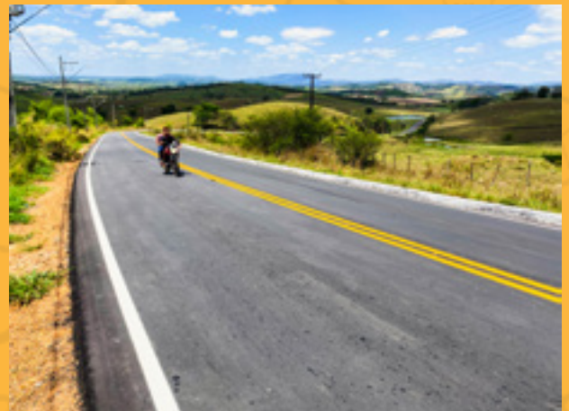
Serviços contemplaram 54,70 quilômetros nos municípios de Riachuelo, Divina Pastora, Malhador e Moita Bonita
