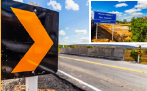
Trecho da rodovia SE-290 que interliga os municípios recebe obra após danificação por fortes chuvas em 2022
