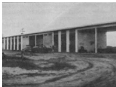
Sede em construção da 4ª Residência em 1974
