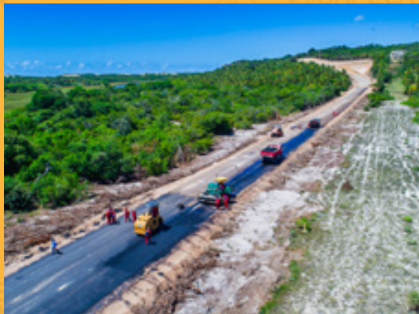
Governo do Estado está concluindo primeira camada de pavimentação asfáltica na rodovia SE-100
