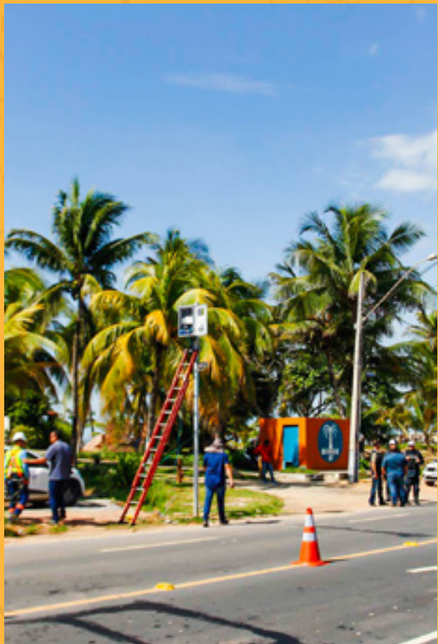
DER/SE acompanha verificação metrológica de radares instalados em rodovias estaduais
