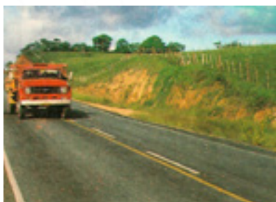
DER chegou a 571,4 quilômetros de rodovias pavimentadas
