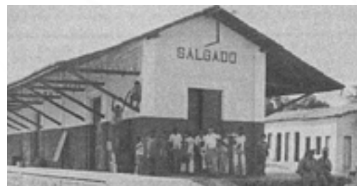
A estação de Salgado foi inaugurada em 1913, na continuação da linha do Timbó, que desde 1887 não era prolongada. Com a chegada dos trilhos até aquela localidade, conhecida então apenas como uma fazenda às margens do rio Piauitinga, o povoado começou a crescer devido às suas águas termais
