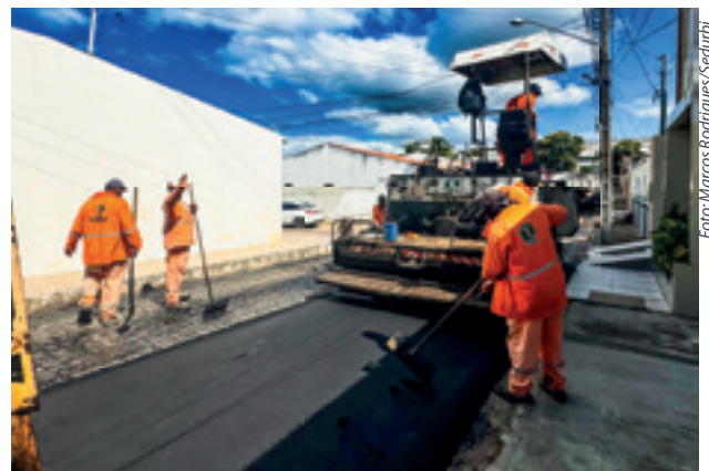
Obras de infraestrutura alegam moradores de Canindé de São Francisco
