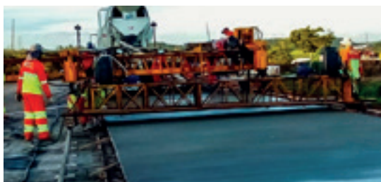
BR-101 Norte - Pavimentação da pista em concreto
