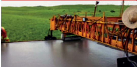
BR-101 Norte - Pavimentação da pista em concreto
